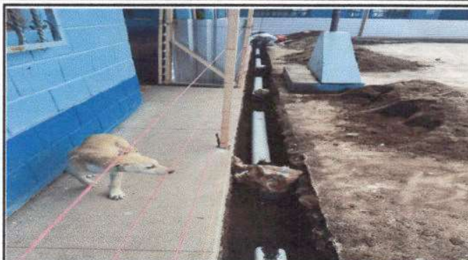
Foto 2: Reparación de drenajes para poder sacar las aguas pluviales del patio de la escuela ya que en tiempo de invierno presenta riesgo para los niños.
