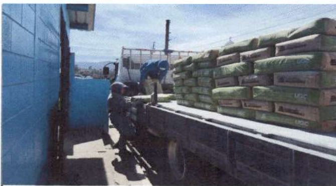
Foto 4: Ingreso de materiales
