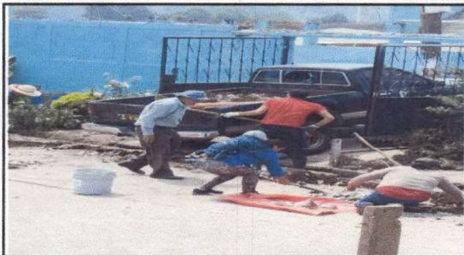
Foto1: Sacando tierra del lugar donde se colocarán los tubos para que corran las aguas pluviales.
