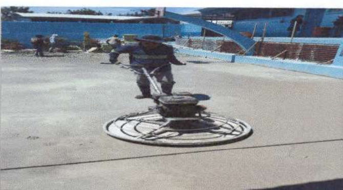
Foto 6: Ya finalizando el trabajo de fundición de loza del patio de la escuela.
